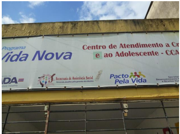
CCA ESCADA – VISITA TÉCNICA
